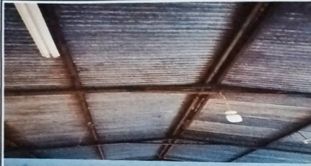
Foto1: MÓDULO 1 AULAS CAMBIO DE LÁMINA, POR LÁMINA ACANALADA ALUZINC CALIBRE 26
