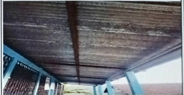
Foto2: MÓDULO 1 AULAS CAMBIO DE LÁMINA, POR LÁMINA ACANALADA ALUZINC CALIBRE 26
